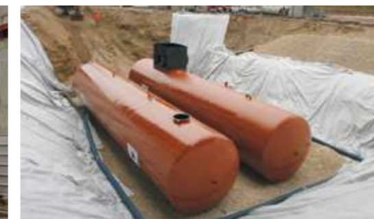
Citernes 100 m 3 DN 3000 connectées ensemble par le bas
