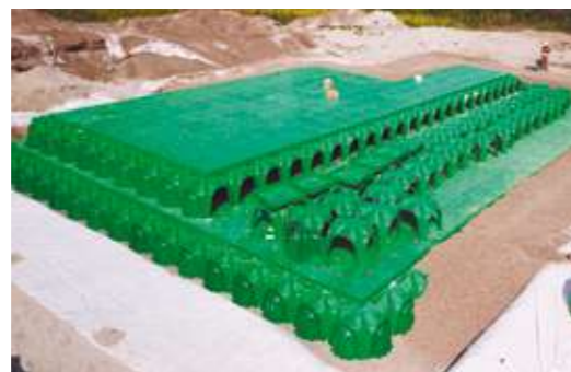
Installation TRITON VOUTE sur deux niveaux
