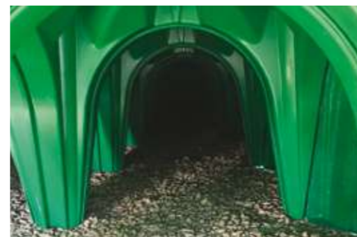
Bassin entièrement visitable
