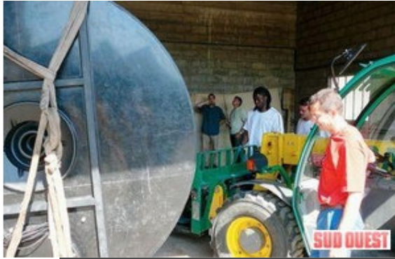
La mise en place du système de récupération d'eau de pluie (dont une citerne de 15 000 litres) par les services techniques de la commune de La Couronne. ( photo philippe rebeix.)
