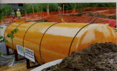
La cuve est pré équipée d'un châssis pré ferrailé qui viendra armé une dalle béton.
